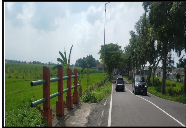
Jembatan Pipa PS 16 STA 10+030 10,5m
