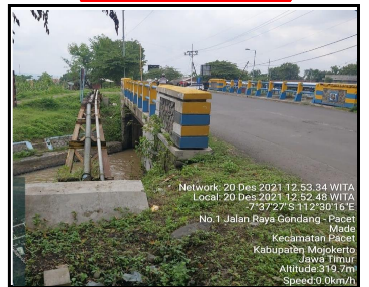
Jembatan Pipa 12 m
