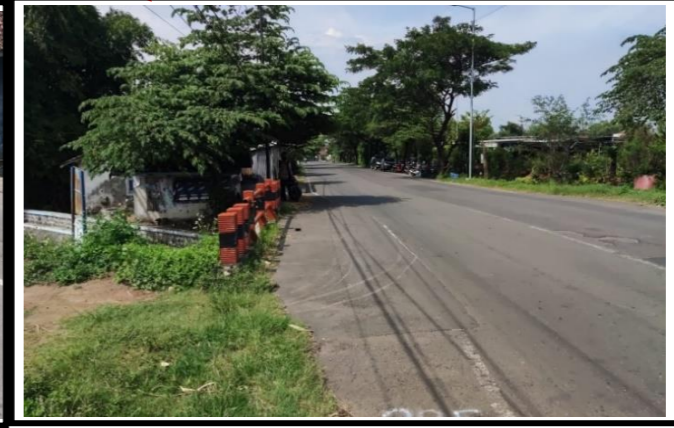
Jembatan Pipa PS 5 STA 2+580 9m
