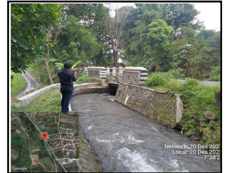
Jembatan Pipa 9 m
