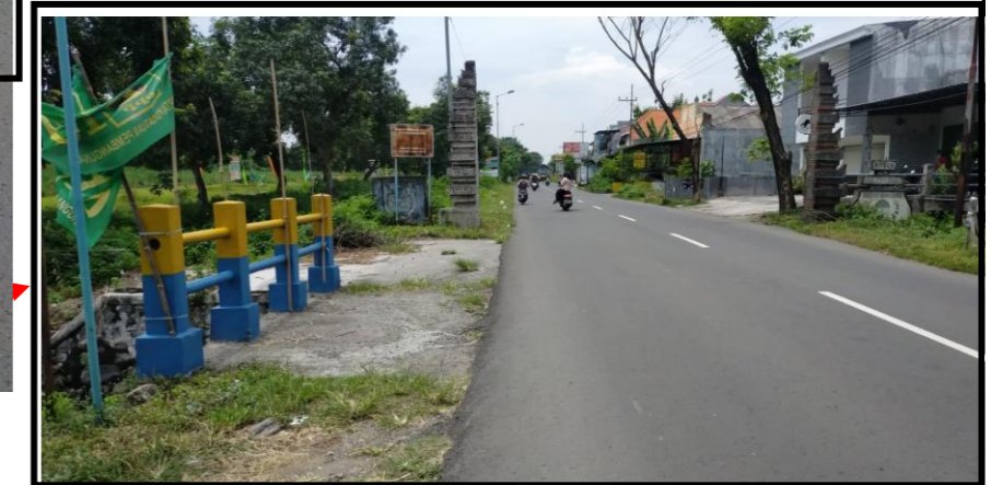
Jembatan Pipa PS 12 STA 8+480 6m
