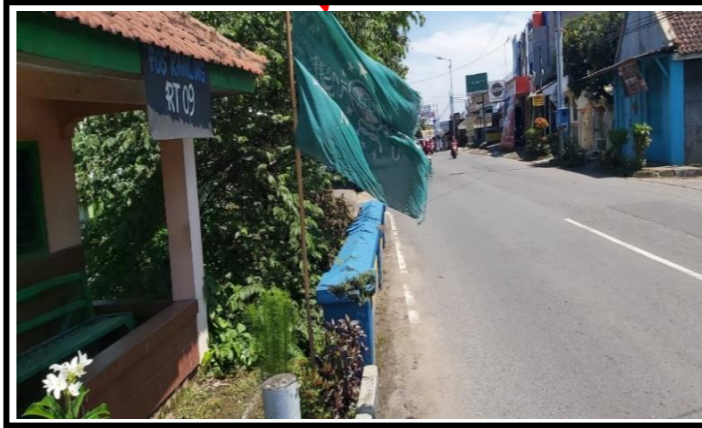
Jembatan Pipa PS 1 STA 0+380 2,5m
