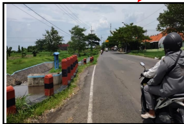
Jembatan Pipa PS 3 STA 0+880 11,5 m
